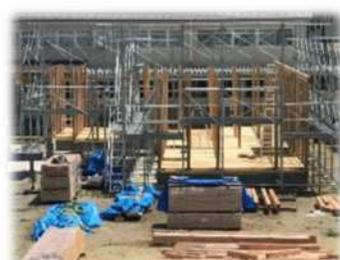
実際の建築現場と同様のプレカット工法による木造住宅の建て方工事を行います。骨組みが立ち上がった後に、床を畳仕上げとする和室を施工します。
