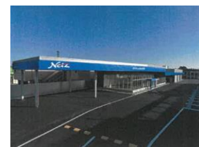
ネットトヨタ仙台(株)築館店建替工事
