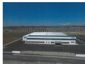
ハイレックス宮城工場建設工事
