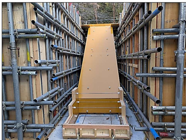
図 11 底板パネルの施工状況
