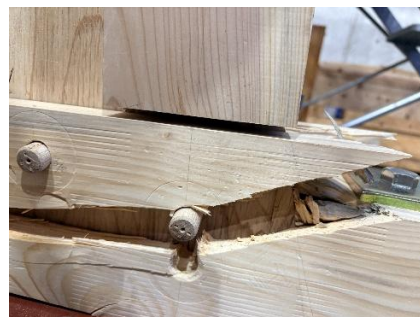
図 3 中柱柱脚破壊性状
