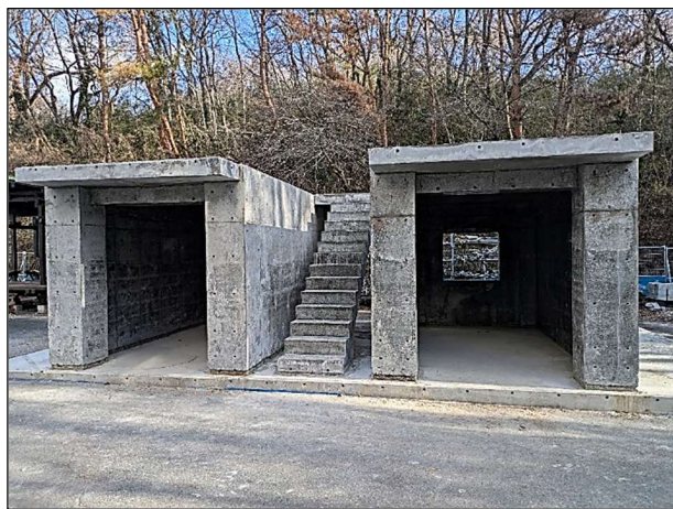
図 15 脱型後の全体
