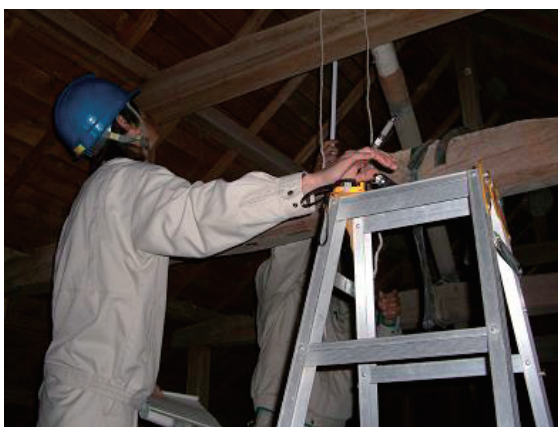
図4 長屋門小屋裏(小屋組み)の実測調査
