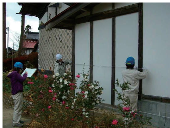
図 14 岩松剛家にて調査 2008年11月18日外部実測調査
