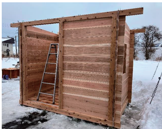
図3 建て方初日の倉庫
