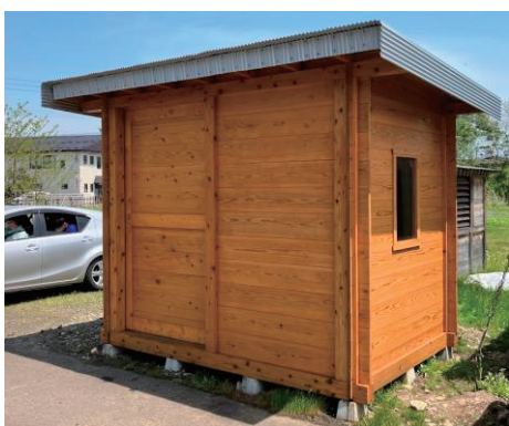
図6 塗装後の倉庫
