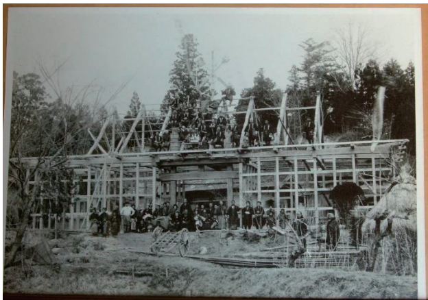
図 7 保存されていた上棟写真(大正 8 年頃)
