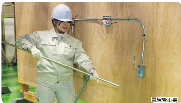
電線管工事
