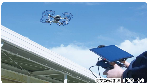
電気設備診断 (ドローン)
