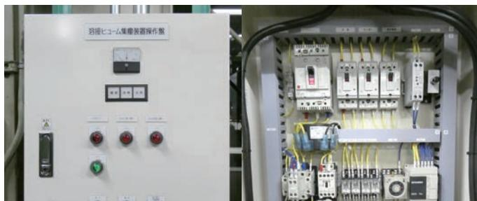
**メモ** 制御盤とは、製造現場に設置されている機械や設備を操作するために、電気部品や電気機器を金属の箱に収めて配線をしたもののことです。
