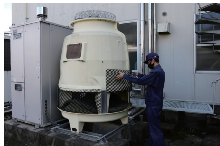
空調設備点検
