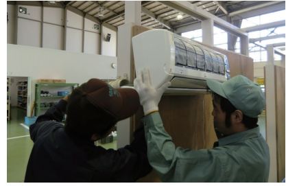
エアコン取付実習
