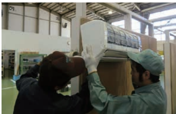
エアコン取付実習
