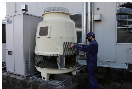
空調設備点検
