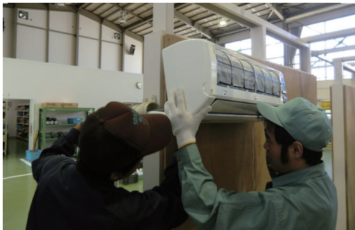
エアコン取付実習
