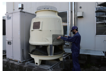
空調設備点検
