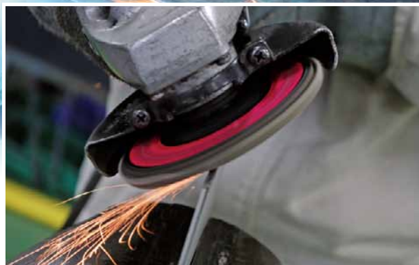
グラインダー作業…金属を削る作業。溶接工には必須の技術です。
