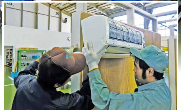
エアコン取付実習
