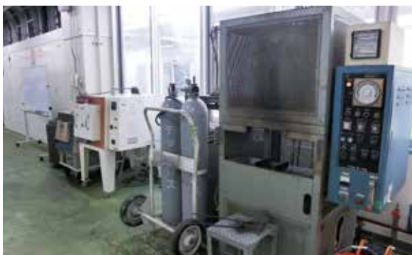
⑦ F棟機械加工実習場 (熱処理炉)
