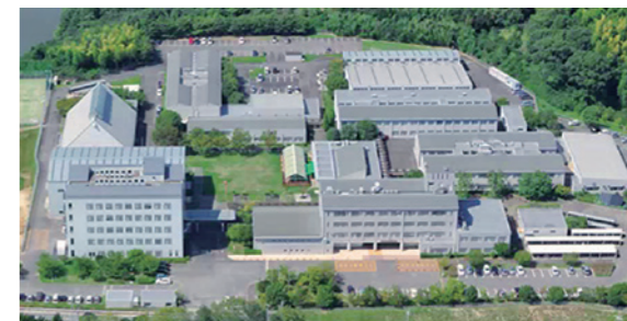
近畿職業能力開発大学校（大阪府岸和田市）
