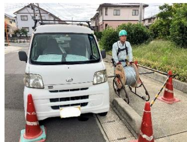
電柱の径間に既設されている光クロージャ（成端箱）から宅内に光ケーブルを引込み、機器を設置し、インターネット回線を開通する工事を担当しています。
