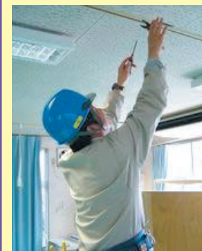
▲ 企業実習（照明の取付補助）
