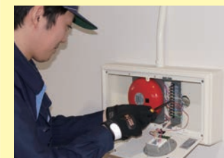
▲ 消防設備の配線実習
