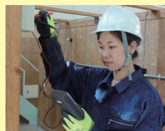
▲ 電気配線の検査
