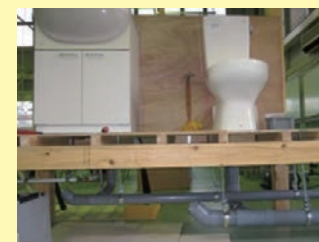
▲ 配管から衛生器具の取付
