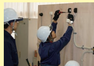
▲ 配管・配線の実習 (ブレーカ取付)
