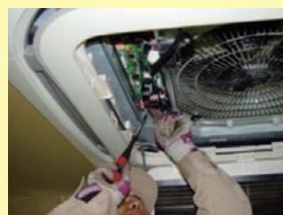
▲ エアコンの設置
