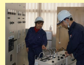
▲ 受変電設備の試験
