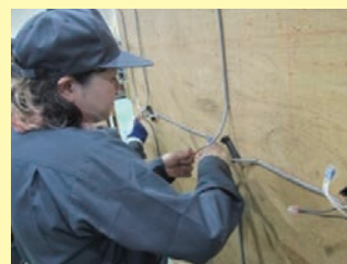
▲ ケーブル配線 電線接続
