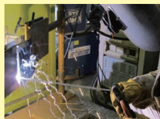
▲ 被覆アーク溶接の風景
