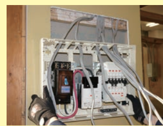
▲ 住宅配線 (分電盤の取付)
