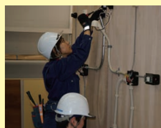
▲ 電気配線の施工実習
