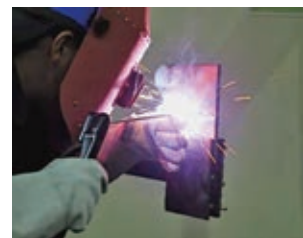
中板(9mm)横向き突合せ溶接
