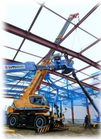
現場で愛機のラフタークレーンを操って作業をしている櫻井さん
