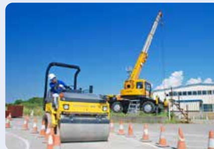
振動ローラーによる締固め作業
