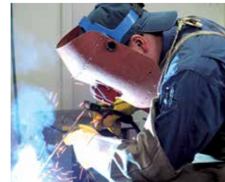
被覆アーク溶接作業
