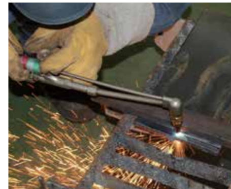
ガス溶断作業
