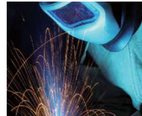
炭酸ガスアーク溶接作業
