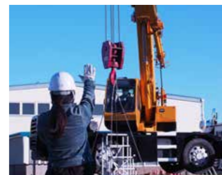
クレーンによる玉掛け作業
