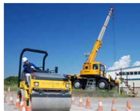
振動ローラーによる締め作業
