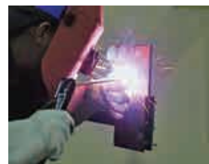
中板(9mm)横向き突合せ溶接
