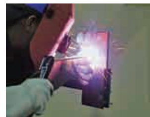
中板(9mm)横向き突合せ溶接
