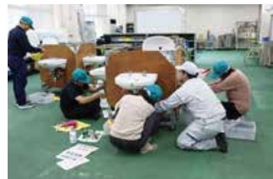
給排水・衛生設備実習風景
