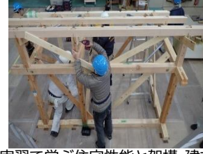
実習で学ぶ住宅性能と架構・建方(建方編)
