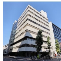
株式会社百十四システムサービス 本社入居ビル外観
