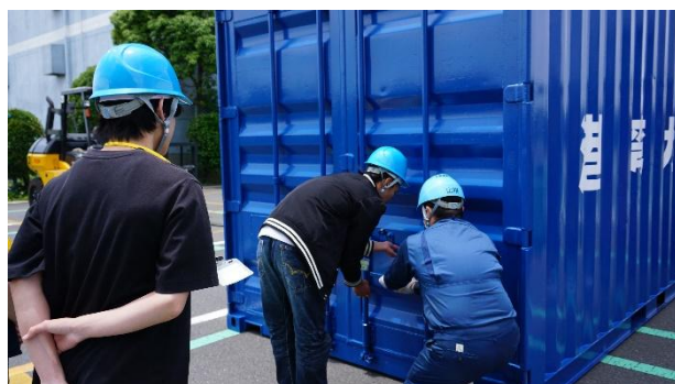
コンテナドアの開閉作業
