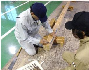
木造住宅の中でもリフォームが増えている在来軸組構法の一軒家を自分たちの手で建てていきます。大工道具・木工機械の使い方に加え、木造住宅の構造の理解を深めていきます。
