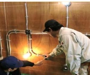
電気工事の基礎から学んでいきます。工具の扱い方、配線図の読み方などを学び、ケーブル工事や金属管工事の訓練を行います。
