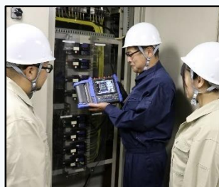
▲ 電気設備のトラブル対策実習
