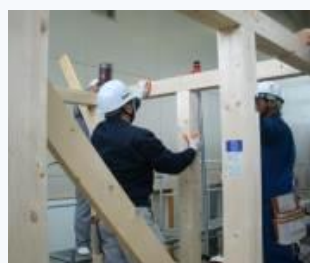
▲ 木造軸組加工法による建物組立の実習
