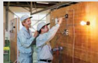
電気工作物設計・施工・検査実習
