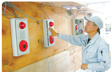
消防設備保全作業
