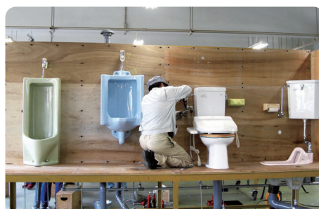
給排水衛生設備作業
