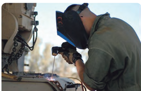
被覆アーク溶接作業
