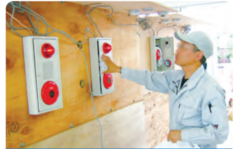
消防設備保全作業
