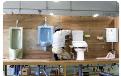
給排水衛生設備作業
