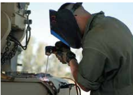
被覆アーク溶接作業
