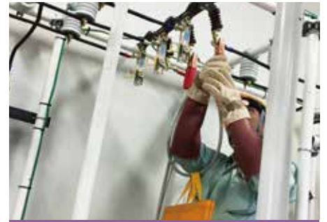
高圧設備工事
