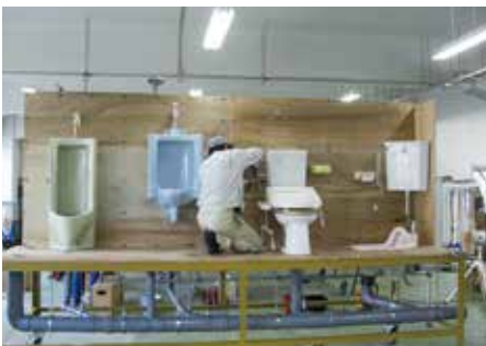
給排水衛生設備作業
