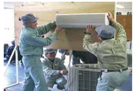
空調設備管理作業
