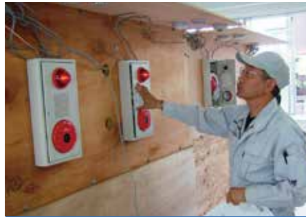
消防設備保全部作業
