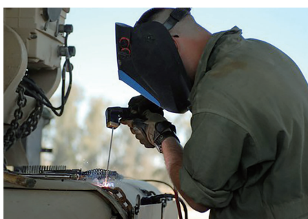
被覆アーク溶接
