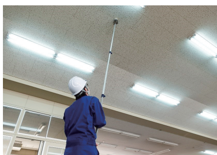
消防設備工事
