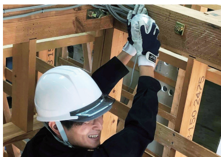
低圧設備工事 実践
