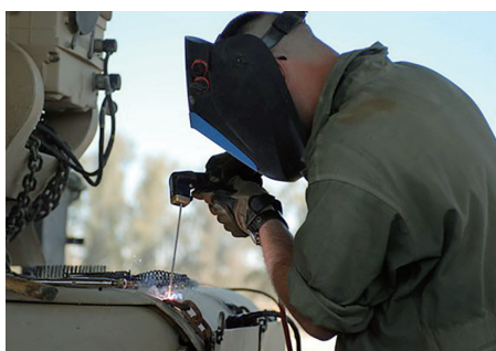
被覆アーク溶接
