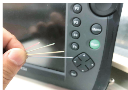
通信設備工事
