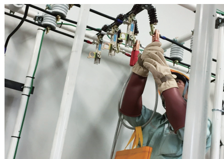
高圧設備工事
