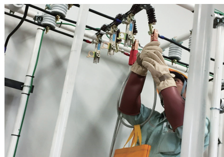
高圧設備工事
