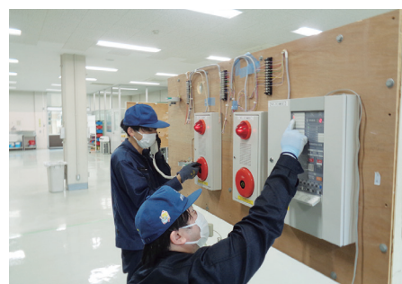
消防設備保全作業
