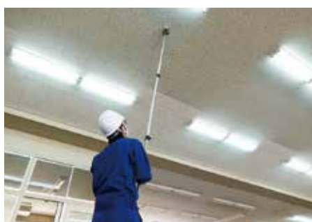
消防設備工事
