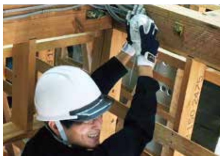
低圧設備工事 実践
