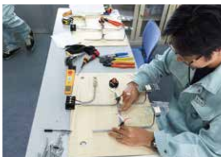
低圧設備工事 基礎
