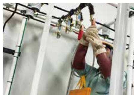
高圧設備工事
