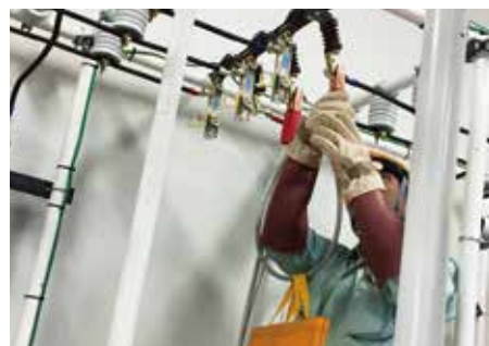
高圧設備工事
