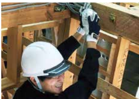
低圧設備工事 実践
