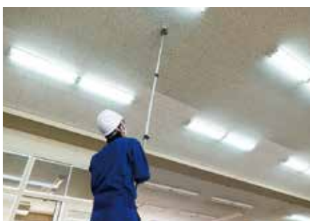
消防設備工事
