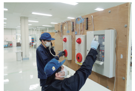
消防設備保全作業
