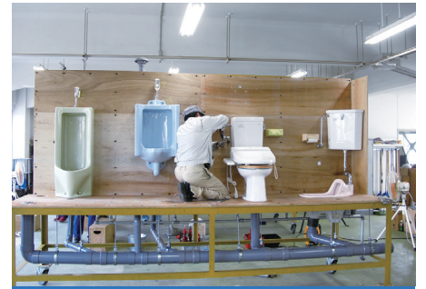
給排水衛生設備作業
