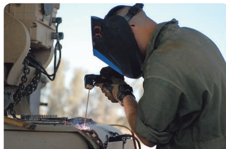
被覆アーク溶接作業
