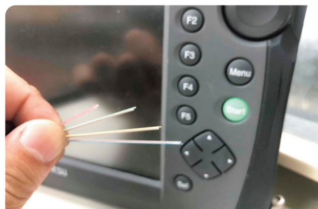
通信設備工事
