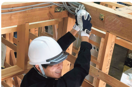
低圧設備工事 実践
