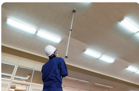
消防設備工事
