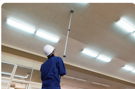
消防設備工事
