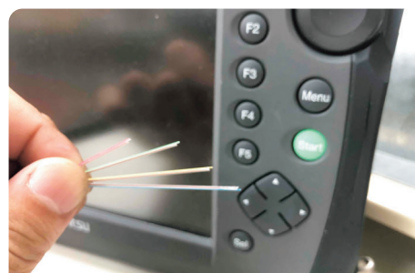
通信設備工事
