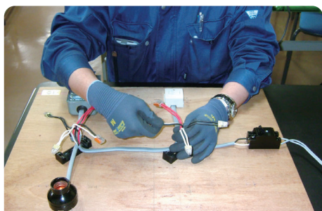
電気配線工事作業
